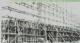
第一期工事 (南館) (1953)
